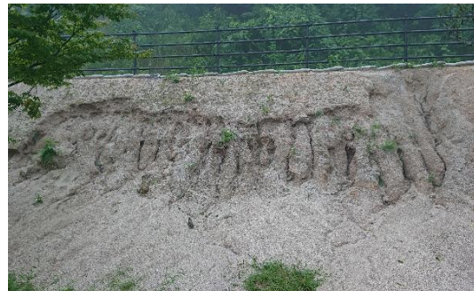
グラウンド横法面崩壊 延長約 50m
