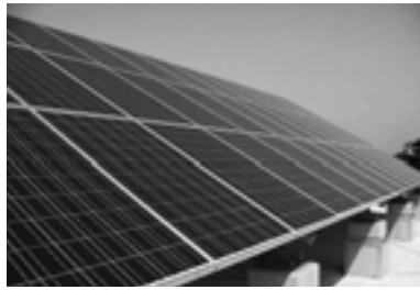
太陽光発電システム
