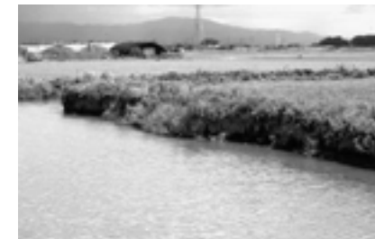
崩落しているのり面
