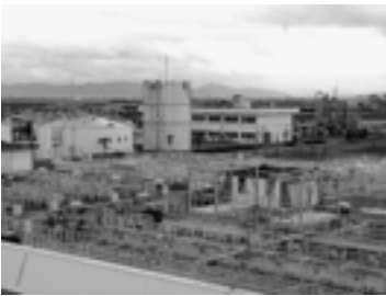
下水浄化センター
