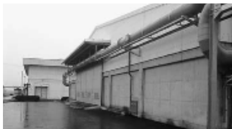
下水汚泥堆肥化施設（西与賀町）
