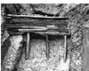
三重津海軍所跡船渠(造船ドック)南岸で見つかった護岸遺構
