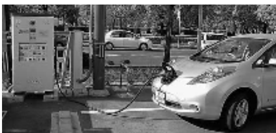
電気自動車充電設備（どん 3 の森南）
