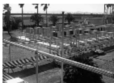
下水浄化センター消化ガス発電設備
