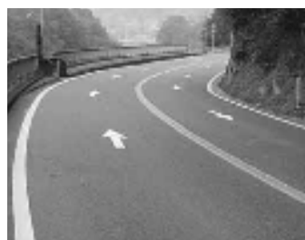
渡月橋付近の危険箇所
