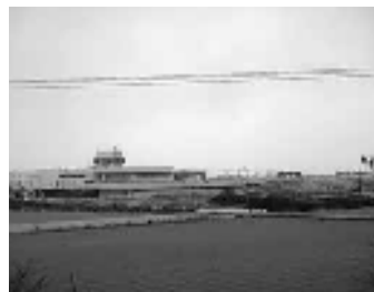
下水浄化センター
