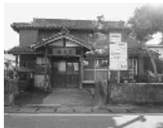
蓮池地区の神埼町自治公民館
