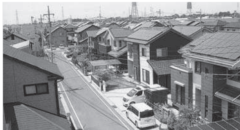
住宅用太陽光発電システム
