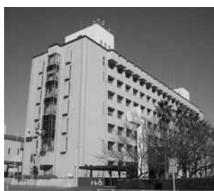
佐賀市役所本庁舎
