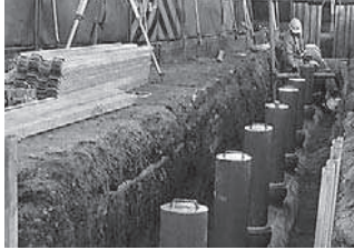
▲災害用マンホールトイレの設置工事の様子
