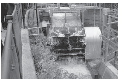
山梨県都留市の小水力発電施設
