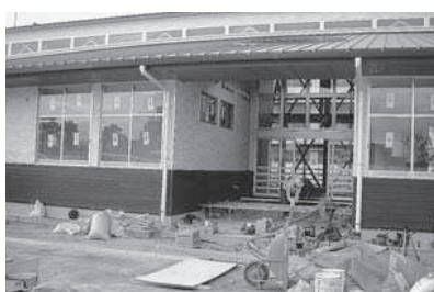
新栄小学校改築工事
