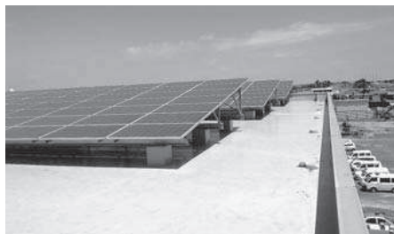
太陽光発電システム設置（鹿嶋市役所屋上）
