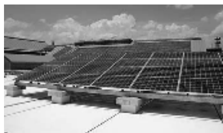
ソーラーパネル（市立図書館屋根）
