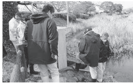
多布施川試験通水の様子
