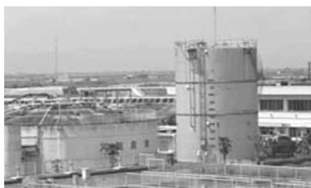
下水浄化センター
