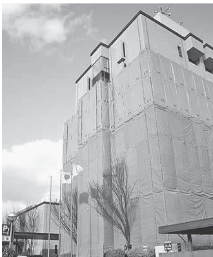
▶佐賀市役所本庁舎
