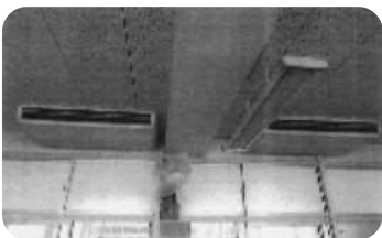
学校に設置されたエアコン
