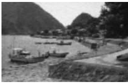
公共事業（漁港工事）
