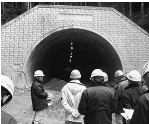
市道大野大串線トンネル工事現地視察
