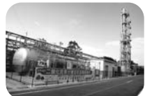
二酸化炭素分離回収設備
