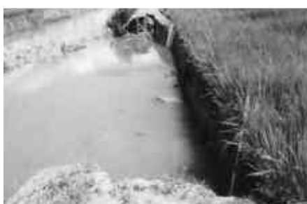
崩落した圃場内水路（土水路）
