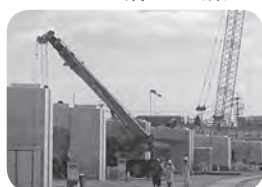
建設中の有明海沿岸道路
