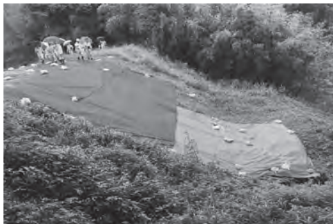
川上のため池を視察（地滑りを復旧中）
