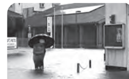
8月13日冠水した勸興公民館前
