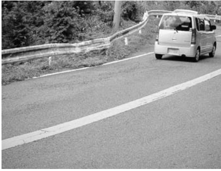
加害者不明のため修理できていないガードレール破損現場
