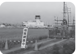
R4年5月 自衛隊配備予定地の地質調査の様子(佐賀空港西側)
