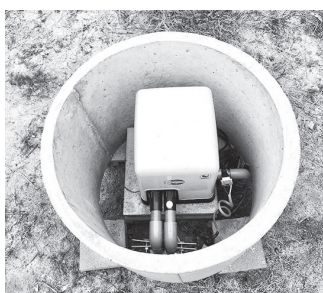
井戸掘削補助と水質検査の実施が望まれている
