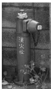
地上式消火栓
