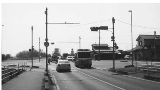
右折レーンがない交差点（久保泉工業団地周辺）
