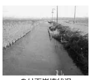
のり面崩壊状況
