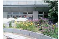
加古川市庁舎新館の屋上緑化
