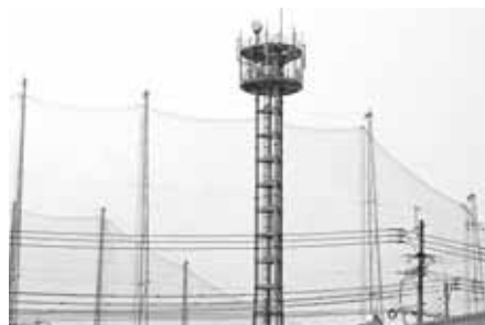
移動通信用鉄塔
