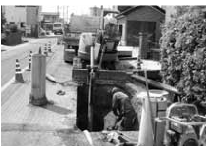
水道管の更新工事
