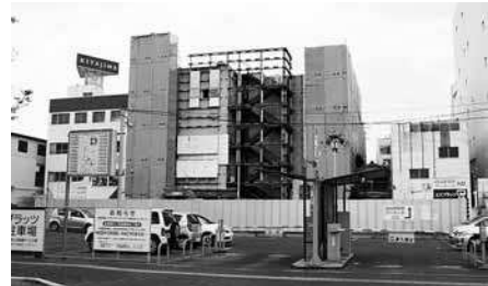
解体される民間ビル
