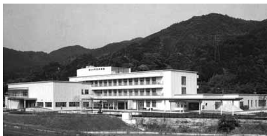
（平成14年7月移転新築・供用開始）
