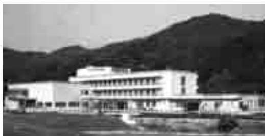
（平成14年7月移転新築・供用開始）
