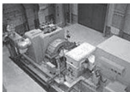
蒸気タービン発電機
