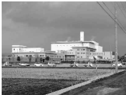
佐賀市環境センター（高木瀬町）
