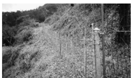
ワイヤーメッシュ設置箇所
