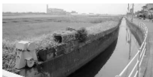
尼寺雨水幹線水路と新工業団地予定地
