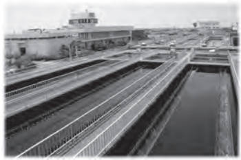
佐賀市下水浄化センター
