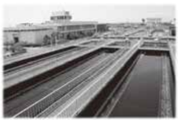
佐賀市下水浄化センター
