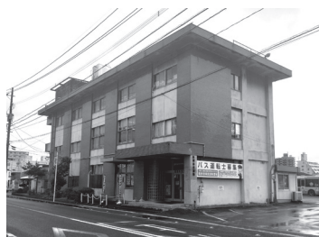
交通局舎は昭和41年2月建築（築58年経過）
