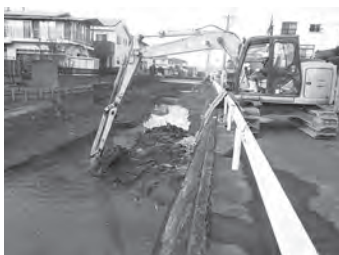
しゅんせつ 浚渫の様子
