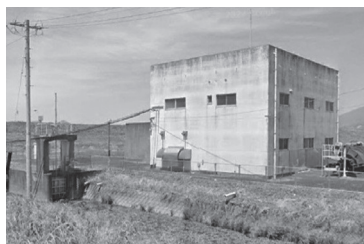
塩土井排水機場 (大和町池上地区)
