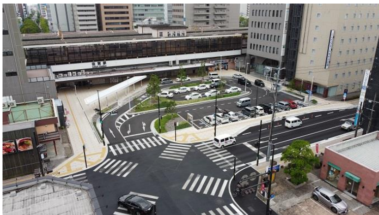
整備後の佐賀駅北口駅前広場
