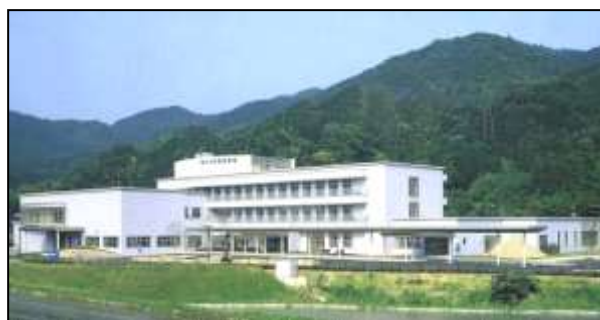
（平成 14 年 7 月移転新築・供用開始）
