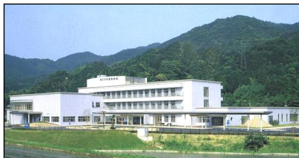
（平成 14 年 7 月移転新築・供用開始）
